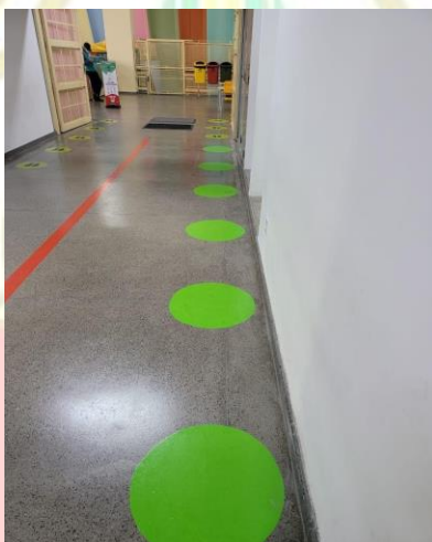
Marcação no corredor
